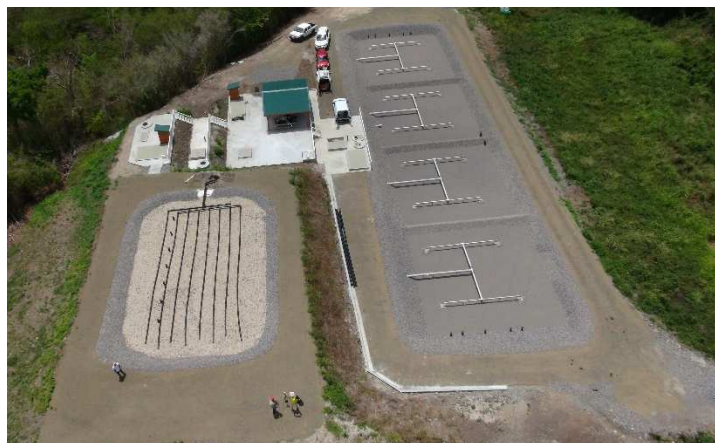
Figure 1 : STEP de Taupinière au Diamant - 1er étage – photo aérienne
